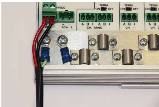
Rys. 12 – Przyłączenie do szyny uziemiającej
